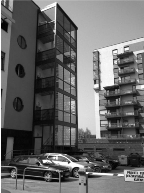
10 paveikslas. Pastato išorinės laiptinės laikančiosios konstrukcijos laikytinos viso statinio laikančiosiomis konstrukcijomis ( nuotr. autoriaus )
