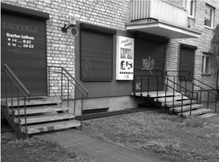
9 paveikslas. Laikančiąja pastato konstrukcija nelaikytini laiptai (nuotr. autoriaus)
