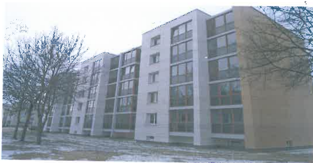
Rmučių g. Nr. 2, Naujoji Akmenė namas apšiltintas ventiliuojamomis fasado plokštėmis.
