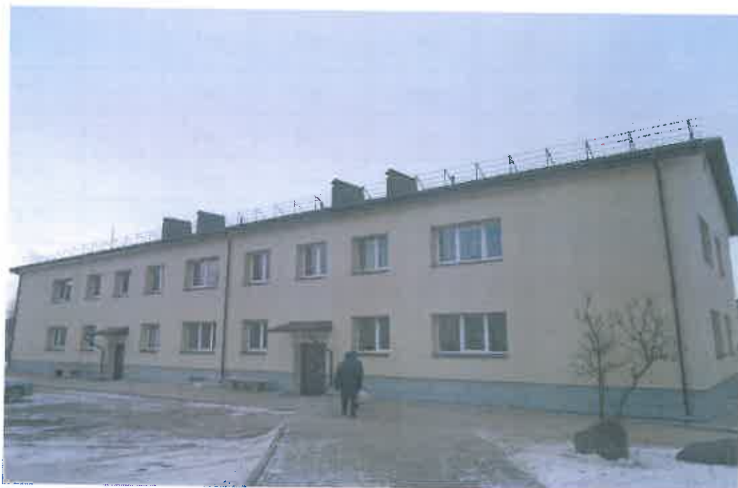
Bausko g. Nr. 8, Venta namas apšiltintas polistirolu plokštėmis aptinkuojant.
