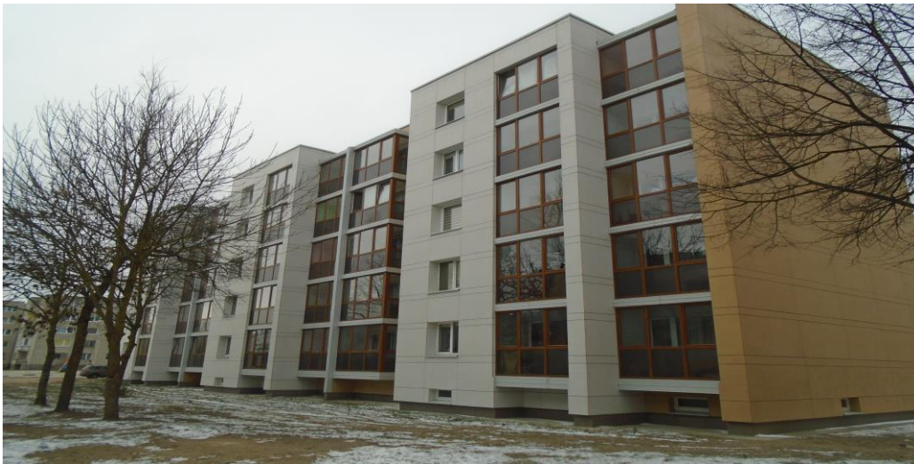
Rmučių g. Nr. 2, Naujoji Akmenė namas apšiltintas ventiliuojamomis fasado plokštėmis.
