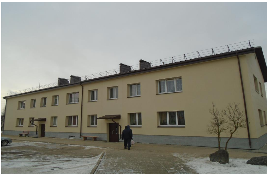
Bausko g. Nr. 8, Venta namas apšiltintas polistirolo plokštėmis aptinkuojant.
