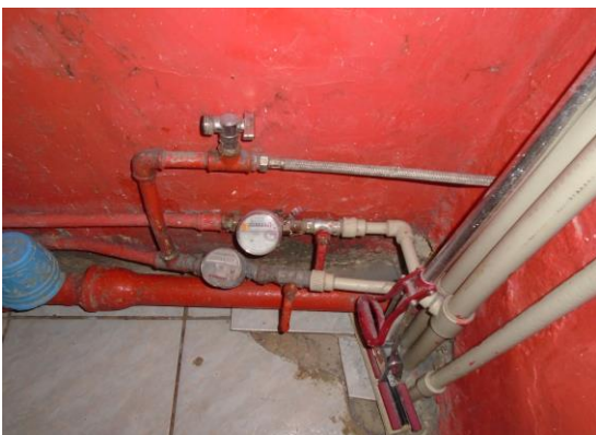
Prieš vamzdynų remontą
